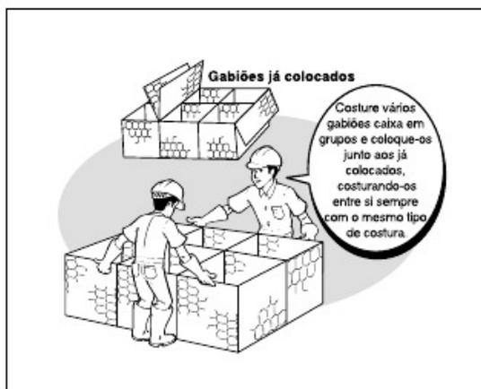
Figura 4 - Posicionamento dos gabões antes do enchimento
