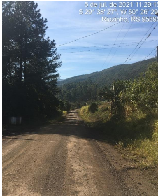
FOTO: Trecho a ser pavimentado
