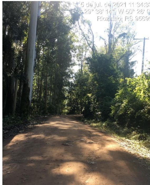
FOTO: Trecho a ser pavimentado
