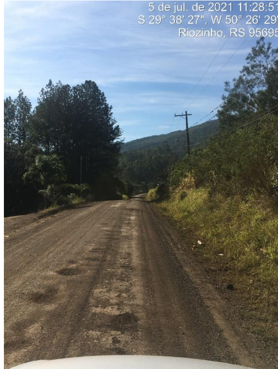
FOTO: Trecho a ser pavimentado
