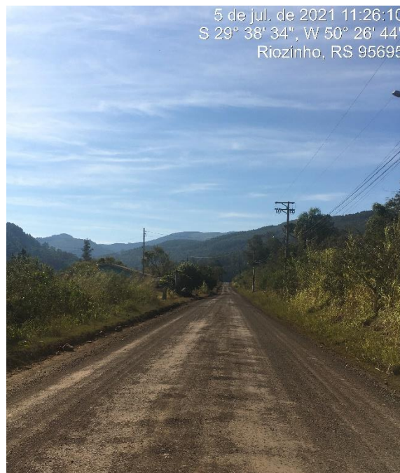
FOTO: Trecho a ser pavimentado
