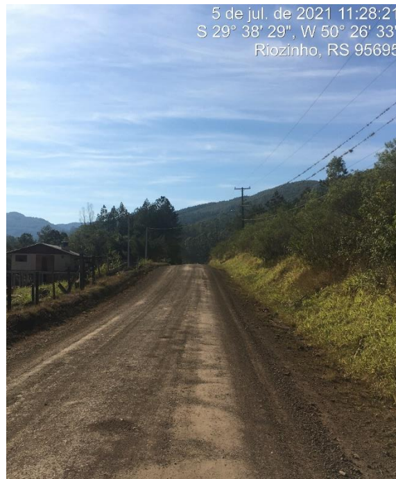
FOTO: Trecho a ser pavimentado
