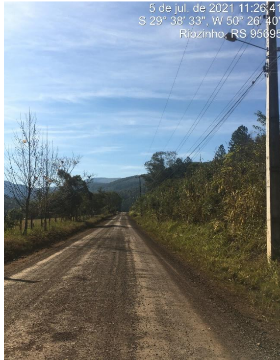
FOTO: Trecho a ser pavimentado
