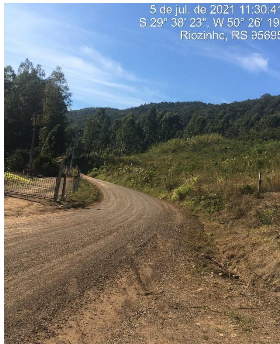
FOTO: Trecho a ser pavimentado
