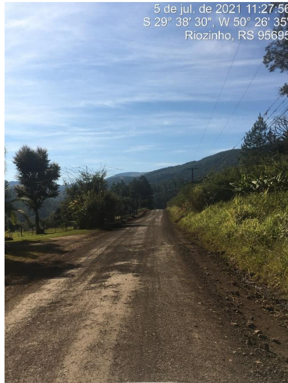
FOTO: Trecho a ser pavimentado
