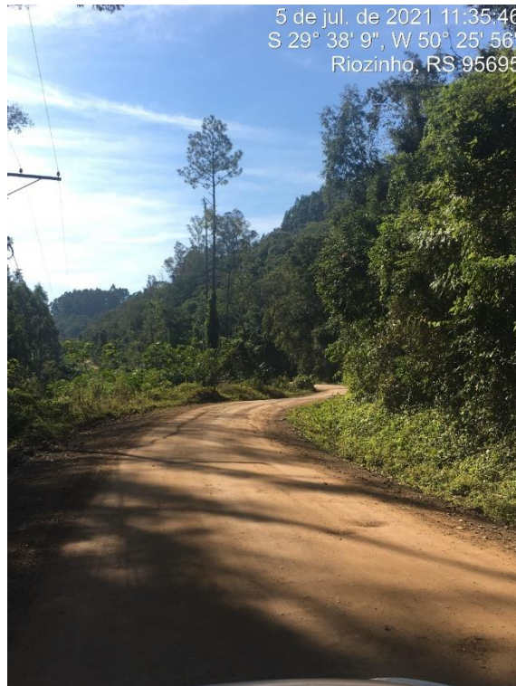
FOTO: Trecho a ser pavimentado
