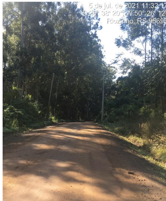
FOTO: Trecho a ser pavimentado
