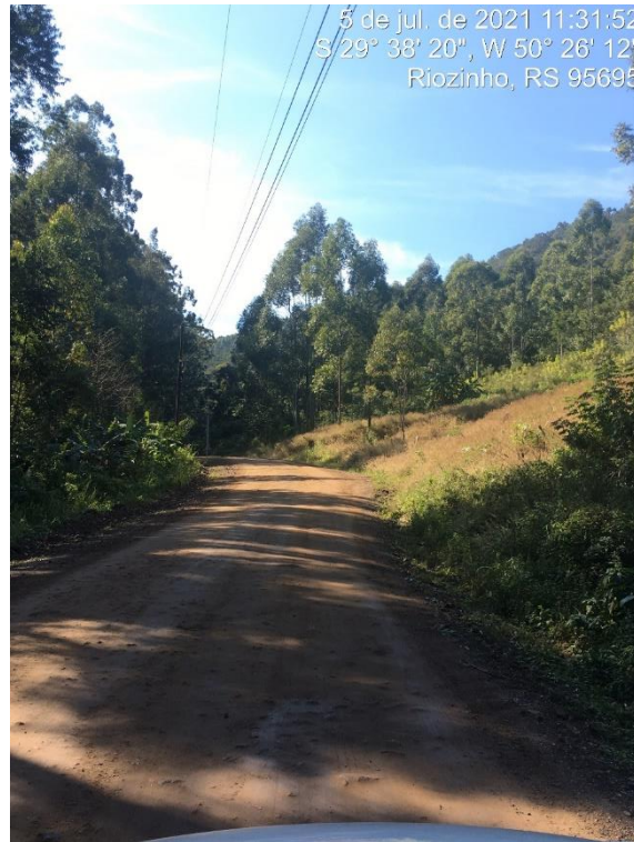
FOTO: Trecho a ser pavimentado
