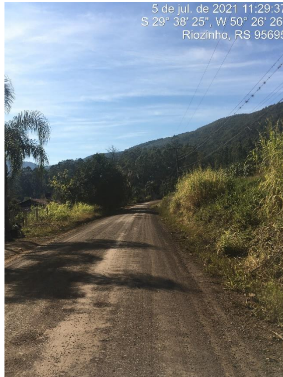
FOTO: Trecho a ser pavimentado
