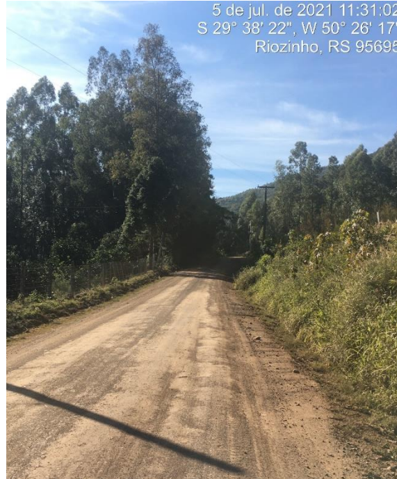
FOTO: Trecho a ser pavimentado
