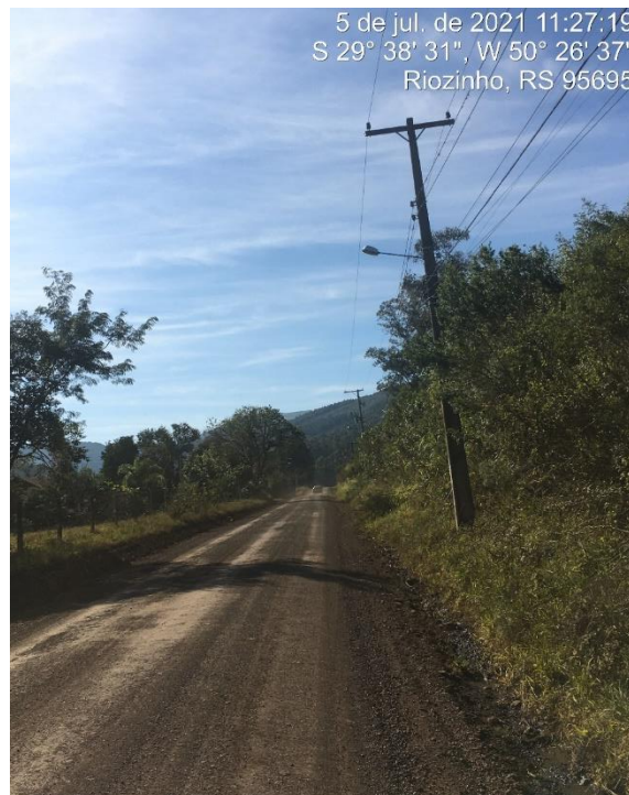
FOTO: Trecho a ser pavimentado
