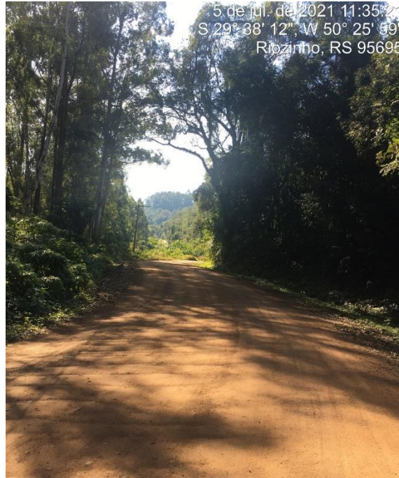
FOTO: Trecho a ser pavimentado
