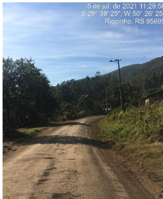
FOTO: Trecho a ser pavimentado
