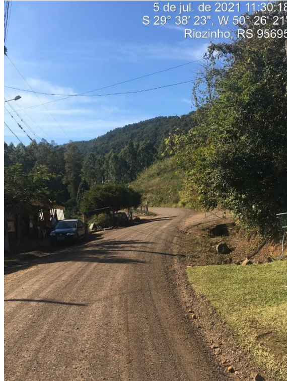
FOTO: Trecho a ser pavimentado
