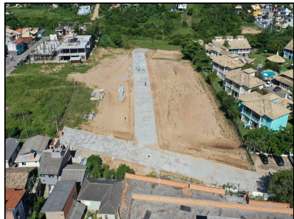
Figura 14. Completa estrutura de campo para monitoramentos e vistorias.
