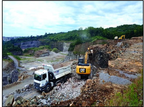
Figura 22. Estrutura de inspeção de campo e acompanhamento de desmontes de rocha.
