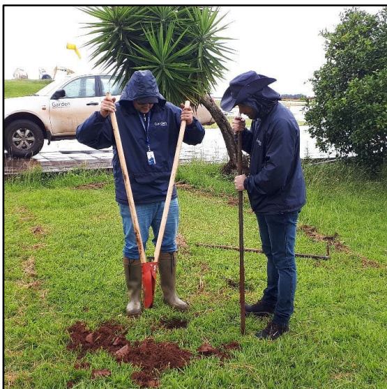
Figura 25. Equipe realizando sondagens de reconhecimento de solo.
