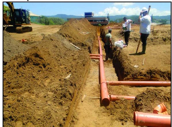
Figura 20. Estrutura de inspeção de campo e acompanhamento de obras de saneamento.
